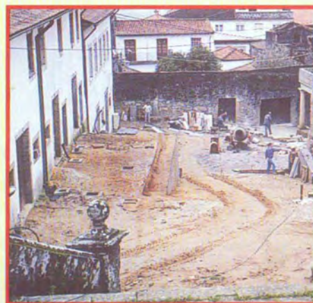
Obras na zona histórica: Largo das Pereiras
