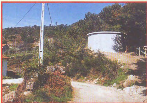
Vitorino de Piães — Depósito para abastecimento de água
