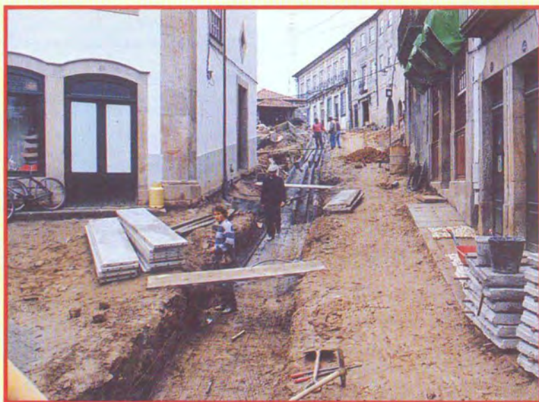
Obras na Rua Formosa
