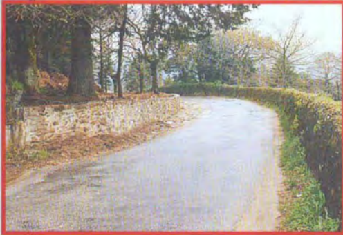
Área — alargamento e construção de muro e passeio na E.N. 307 apoio da J.A.E. e fiscalizada pela Junta de Freguesia de Arca
