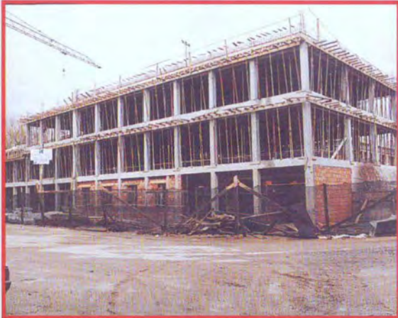
O novo Centro de Saúde de Ponte de Lima em construção
