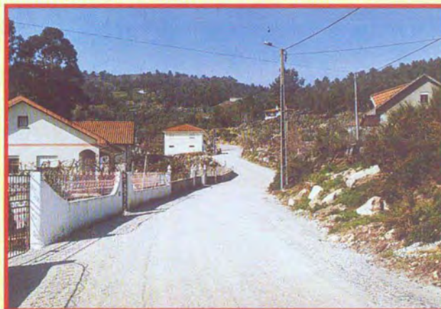
Vitorino de Pitães — Estrada de Airão — Ligação a Santa Leocádia de Geraz do Lima (V. do Castelo)
