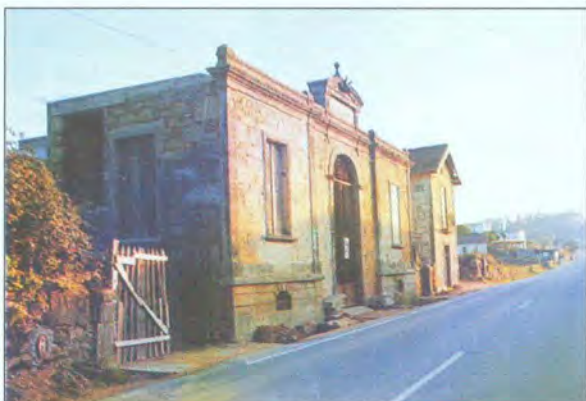
O velho matadouro já em obras para a instalação do Centro de Animação Arte e Cultura
