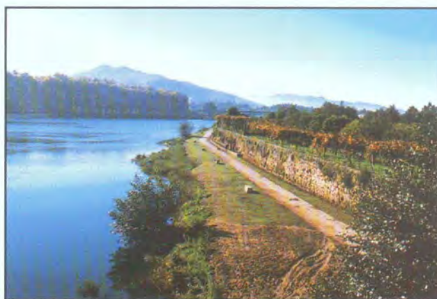
Passeio marginal construído na margem direita do rio Lima
