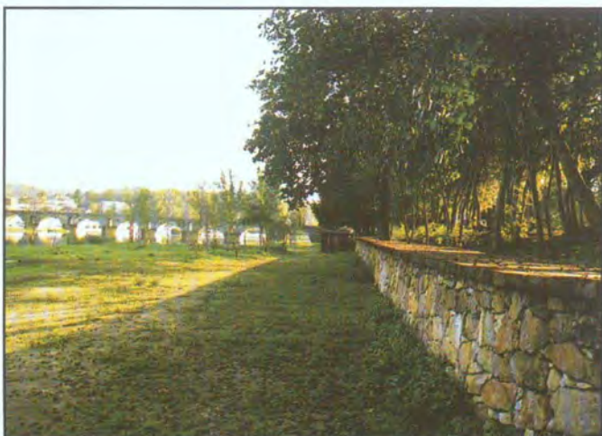
Arcozelo - Praia do Arnado - Aspecto do muro com passadiço superior construído em madeira tratada
