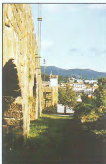
Ponte romana - colocação de escada metálica de acesso ao passeio marginal da margem direita do rio
