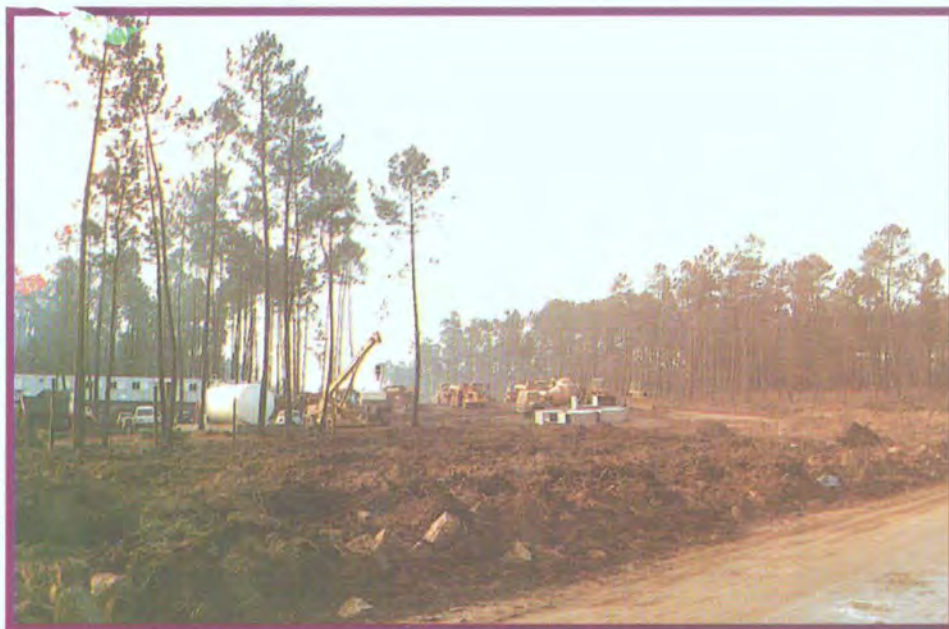
Auto estrada - Trabalhos em Gaifar
