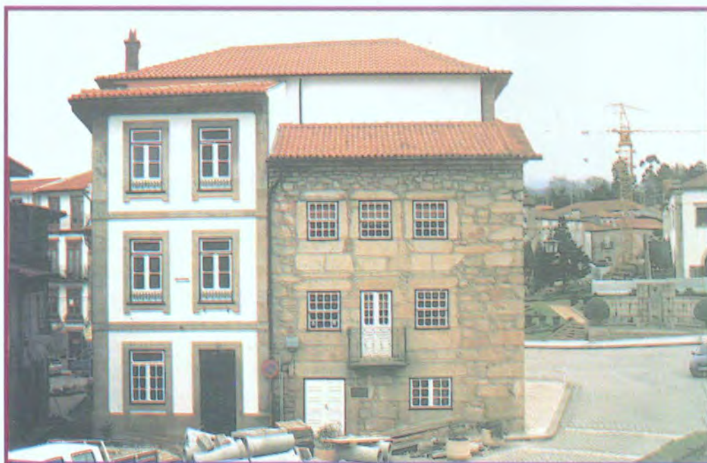
Edifício onde será instalada o GTL
