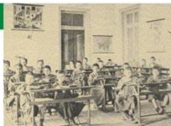
Aspecto de uma sala de aula no início do século.
